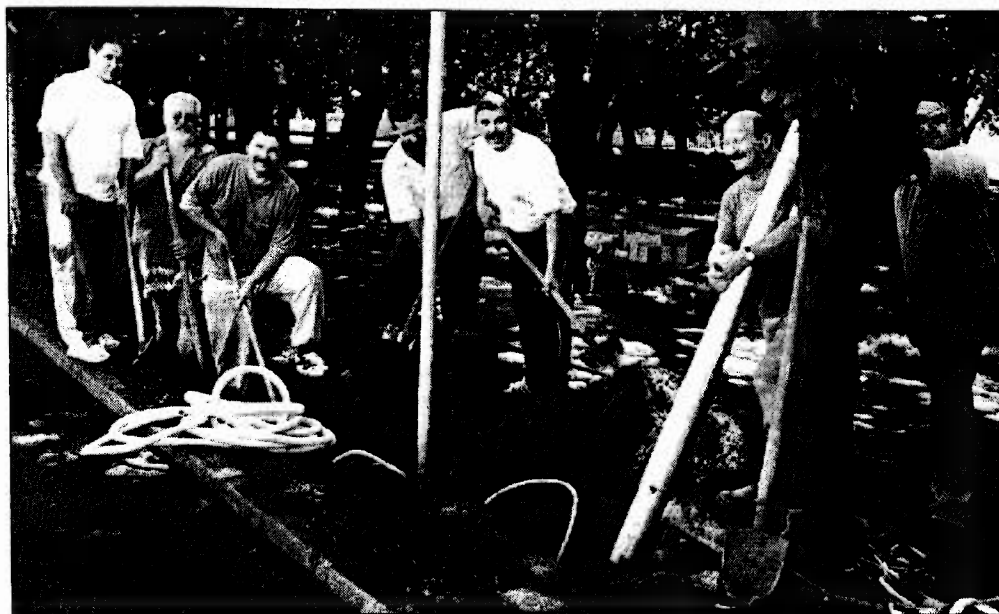
Képünk a Szent Miklós parkban, a kábelek fektetésekor készült
