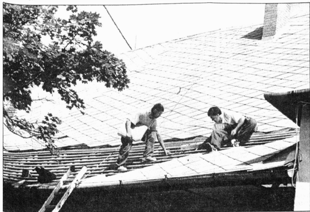
A Gyulai Népfőiskola Kossuth u. 11. szám alatti kollégiumának tavaly megkezdett felújítási munkálatai ebben az évben is folytatódnak. Az épület tetőzetéhez 1935 óta nem „nyúltak”, így igencsak indokolt volt felújítása. Ezt a munkát Varga Zoltán gyomaendrői vállalkozó végezte el (képünk még a befejezés előtt készült). A továbbiakban az épület utcai frontját hozzák rendbe a műemlékvédelmi hivatal előírásainak megfelelően
